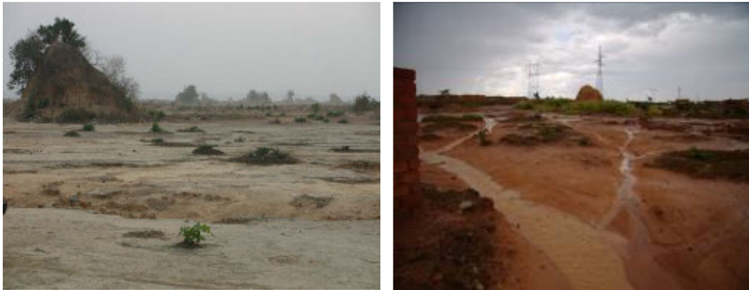
Figure III.10 Vue de l'état du sol dans le quartier en aval (habitations) du terril de Lubumbashi en saison sèche (à gauche) et en saison de pluie (à droite). Source : KAYA, 2008
