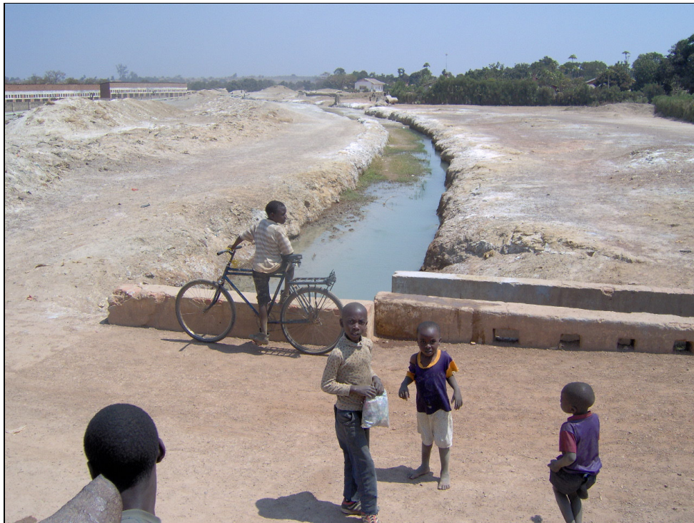
Figure VI.14 Curage et entreposage des sédiments en zone habitée
